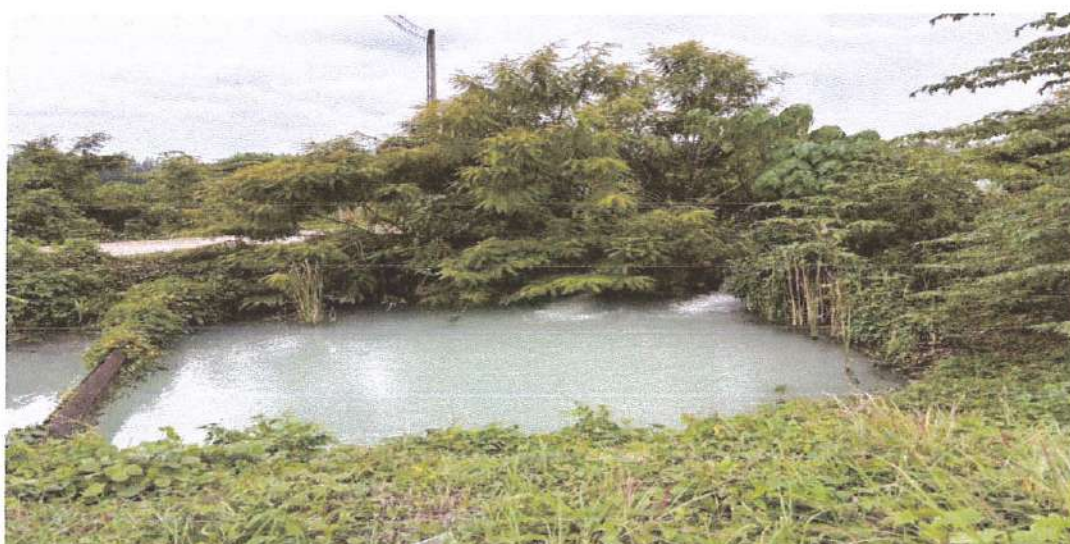
รูปที่ 4 ปอดักตะกอนดินรองรับน้ำจากอุระบายน้ำ และน้ำจากขุมเหมือง
